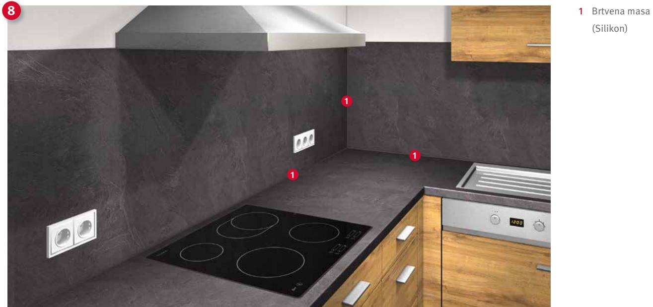
Po završetku montaže panela montiraju se utičnice i brtve se reške i spojevi s radnom pločom, kako bi se sprječio prodor vlage – vidi slike 8 i 9. Gornja fuga prema napi ili zidnim ormarićima ne bi se trebala brtviti, kako bi se omogućio izlaz eventualne preostale vlage.
